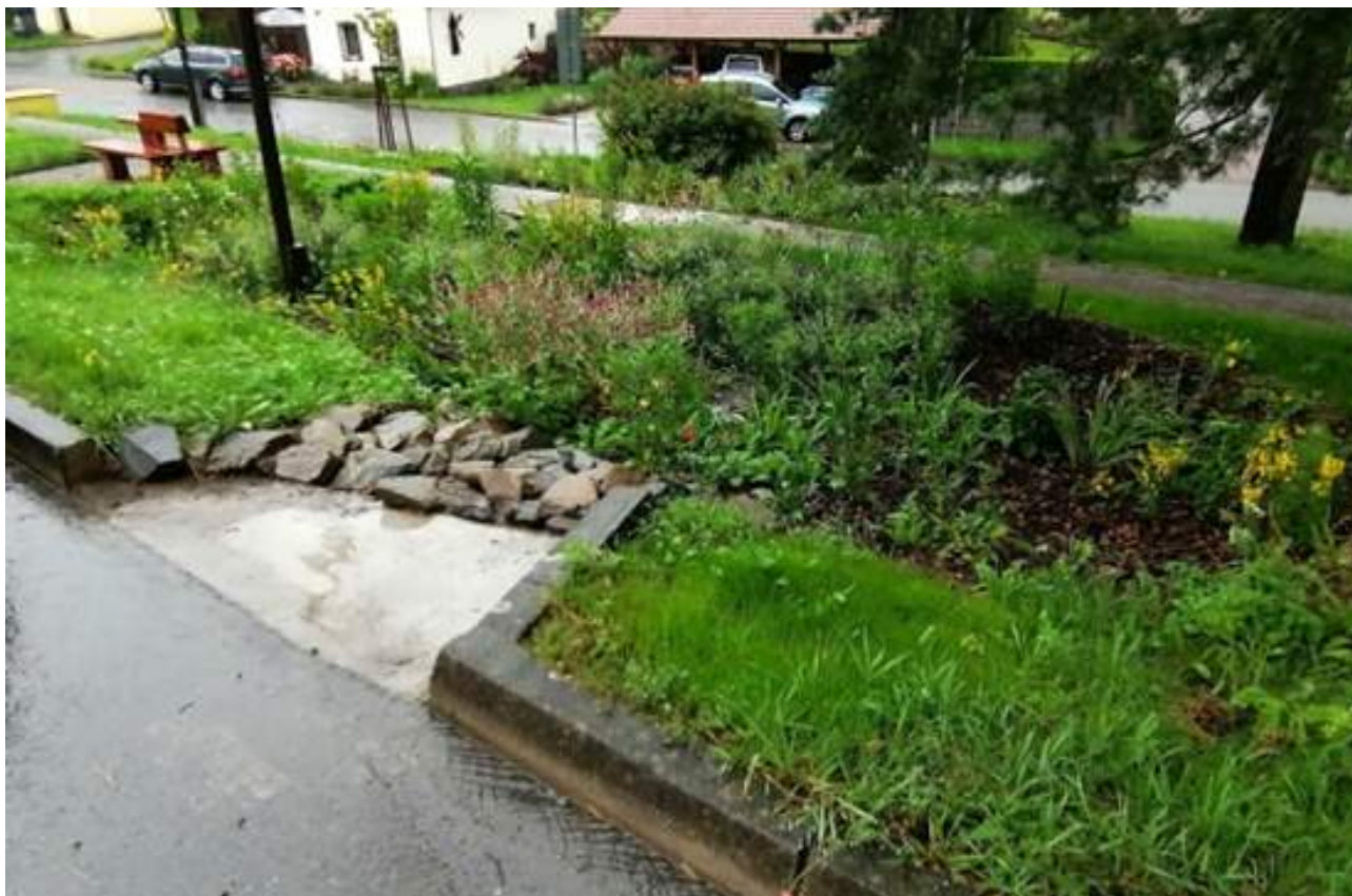
Zasakování vody v centru obce Ruprechtov prostřednictvím dešťových záhonů. Adaptační opatření mohou být zároveň účinná i krásná. Foto: Martina Jurová
