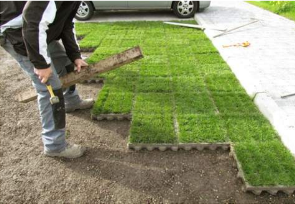
Umožnit zasakování vody a snížit přehřívání lze i na parkovištích. Realizace zatravněné zasakovací dlažby. Foto: Asio, spol. s.r.o.
